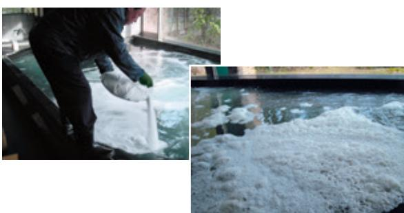
A剤投入後、循環ライン(ろ過機・配管)に付着していたバイオフィルムや各種の汚れが、浴槽内に浮上してきます。
