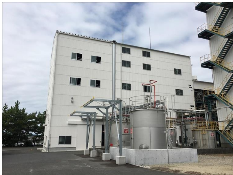
小野田工場 グレースシア（NC-515）原体製造設備
