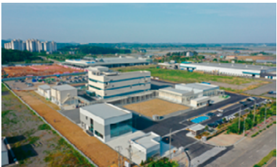
NCK 唐津工場(2023年5月稼働)
