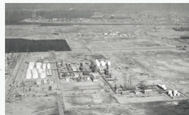
日産石油化学千葉工場(1968年頃)
