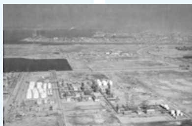
日産石油化学千葉工場(1968年頃)
