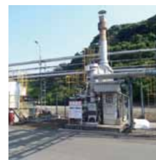
排ガス燃焼装置
