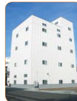
小野田工場 農業プラント
