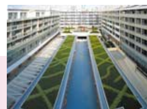
屋上緑化工事
