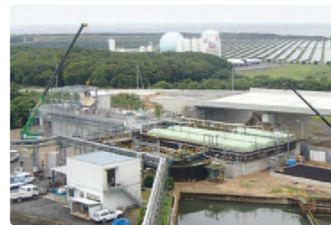
排水処理施設増強工事
